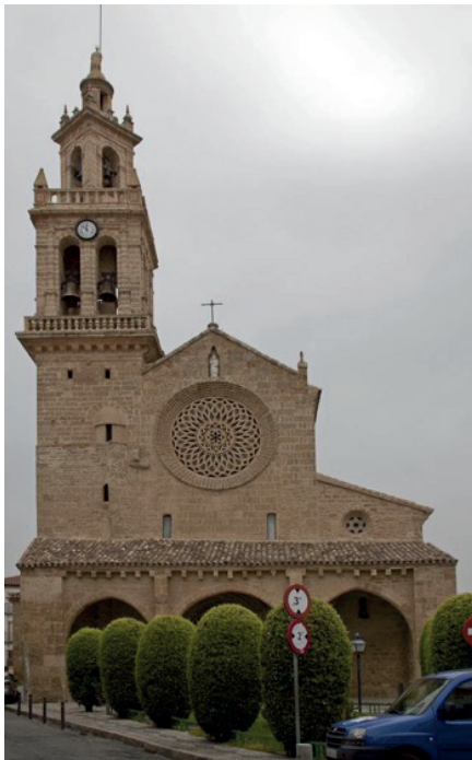
Fig. 6. Fachada principal, pórtico y torre de la iglesia de San Lorenzo. Córdoba. Torre de Hernán Ruiz II. Circa 1555. Fotografía del autor.
